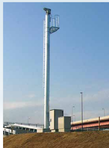
国土交通省関東地方整備局 荒川下流河川事務所様
